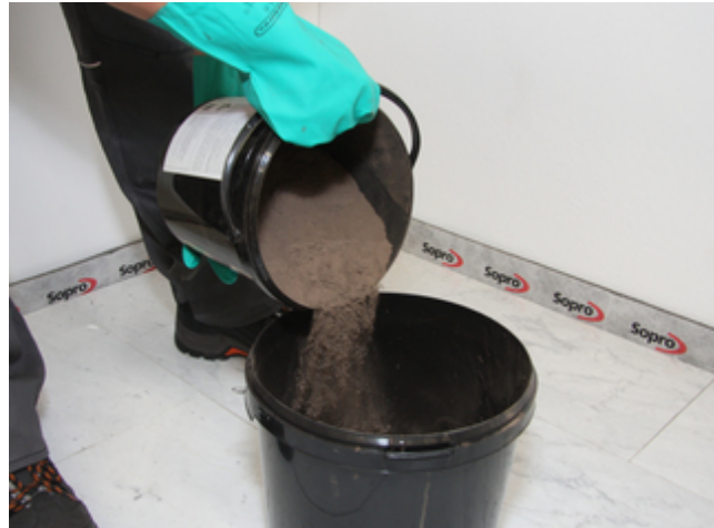
2 Sopro DF 10 zudosieren und maschinell anrühren.
