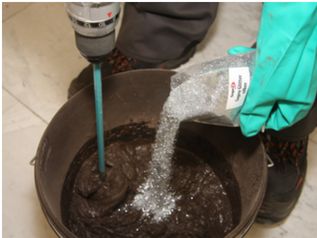
3 Optional kann dem Fugenmörtel Sopro Glitter gem. Dosierung während des Anmischvorganges zugemischt werden. Dazu den Wasseranteil gem. TPI des Fugenmörtels erhöhen.
