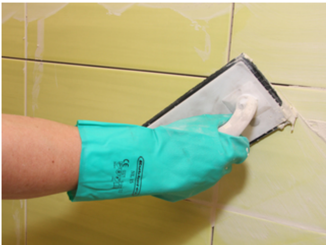
9 Einfugen von Sopro DF 10 in Steingutfliesen.
