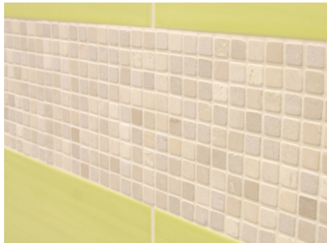
10 Steingut- und Natursteinmosaikflächen verfugt mit Sopro DF 10.
