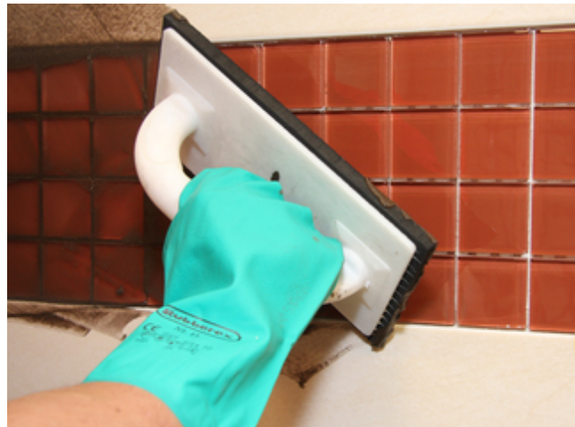
4 Einfugen von Sopro DF 10 mit Glitter silber in Glasmosaik.
